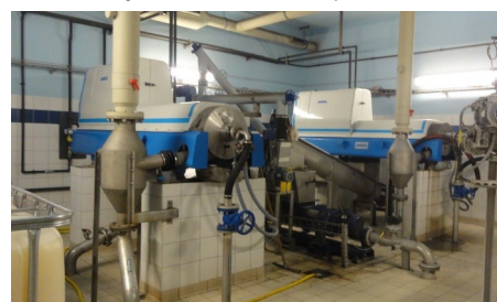
Déshydratation des boues d'épuration
