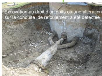
Excavation au droit d'un puits où une altération sur la conduite de refoulement a été détectée
