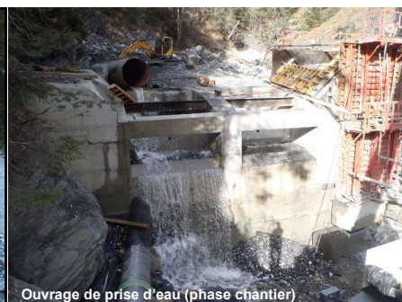
Ouvrage de prise d'eau (phase chantier)
