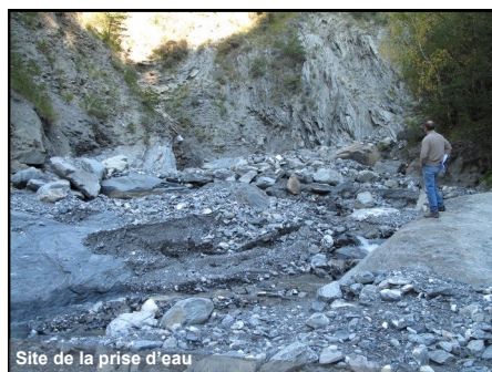
Site de la prise d'eau
